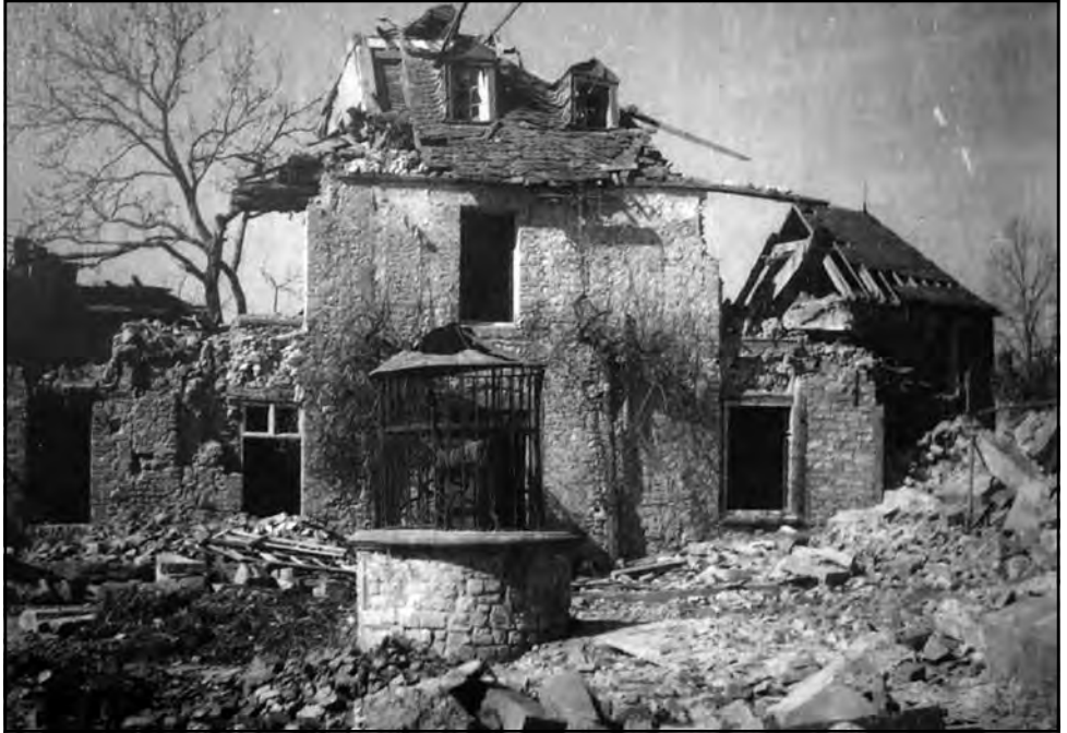
Die zerstörte Propstei von 1945 und im Hintergrund das Pastorat am Mühlenberg
